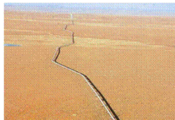
變成U形的輸油管，是爲了預留熱脹冷縮的空間而設
